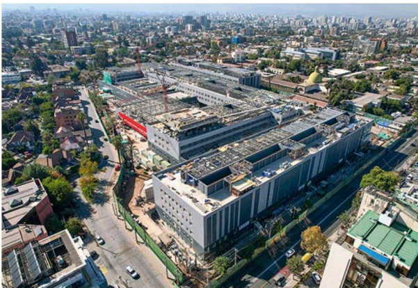
Hospital del Salvador e ING · Santiago · 174.000 m 2 · 641 camas
